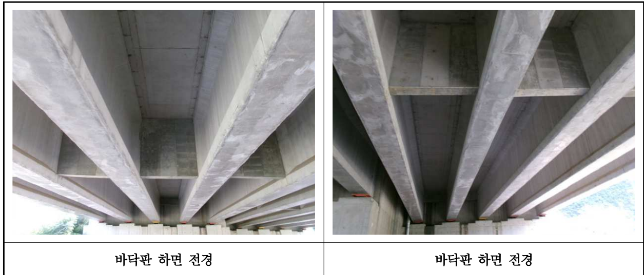
【사진 17.3.27】 바닥판하면 전경
