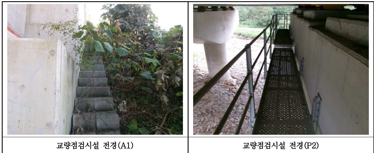
【사진 17.3.25】 교량 점검시설 전경
