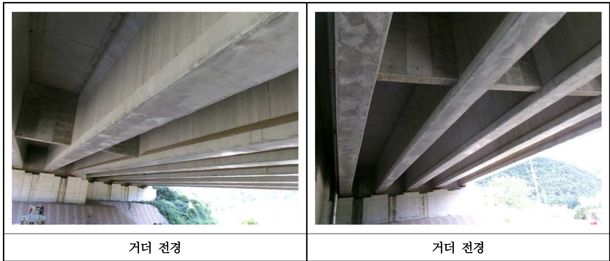
【사진 17.3.29】 거더 전경
