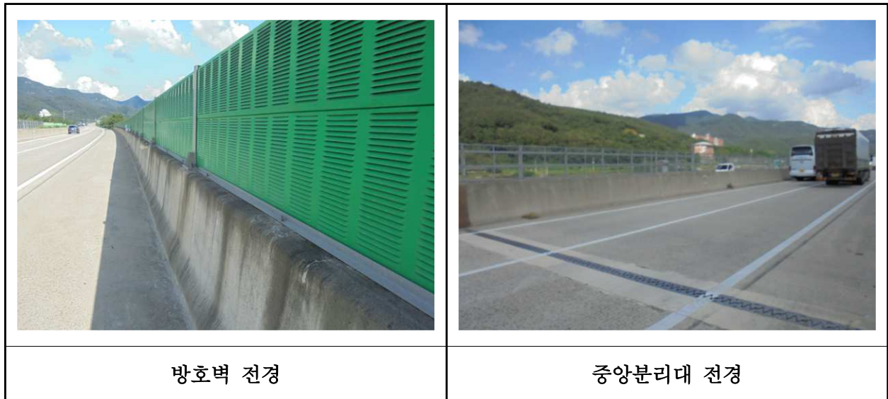
【사진 17.3.48】 방호벽 및 중앙분리대 전경
