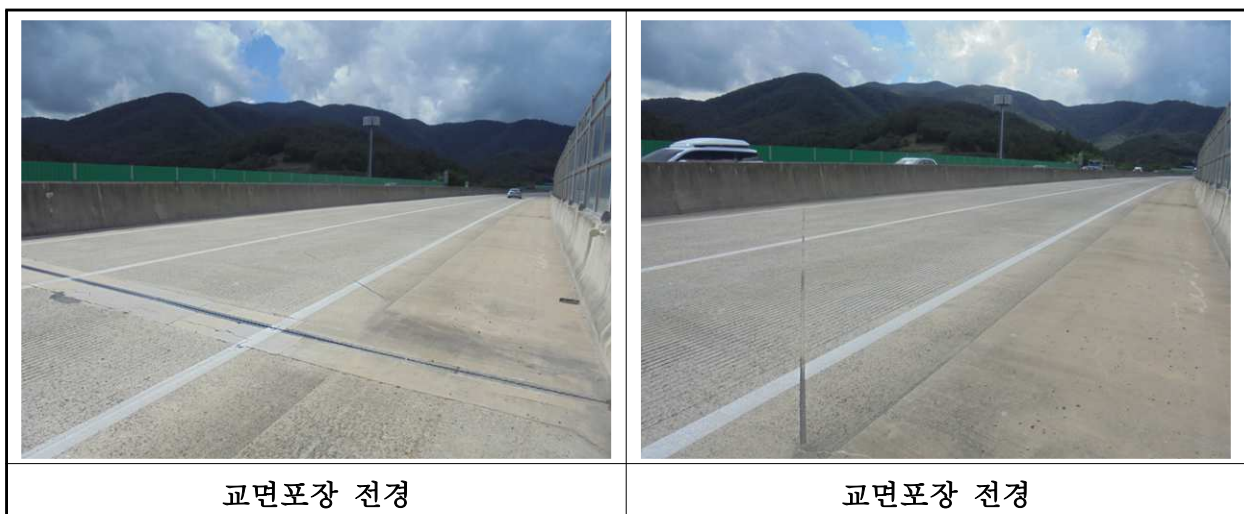
【사진 17.3.19】 교면포장 전경
