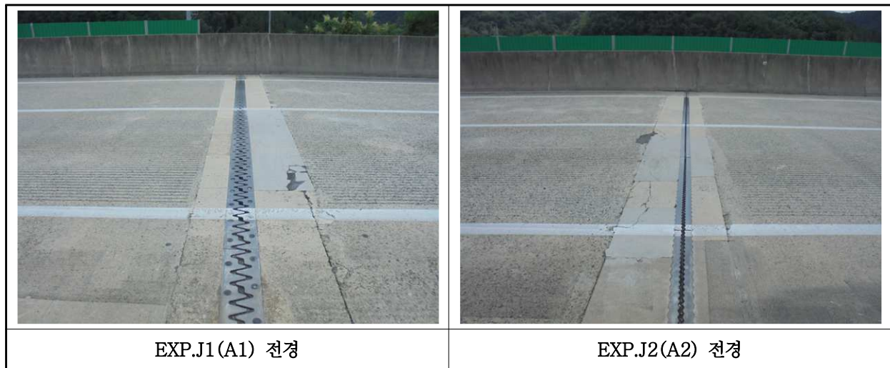
【사진 17.3.16】 신축이음장치 전경
