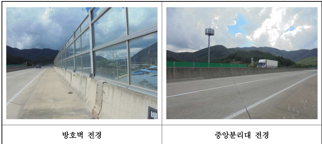
【사진 17.3.23】 방호벽 및 중양분리대 전경
