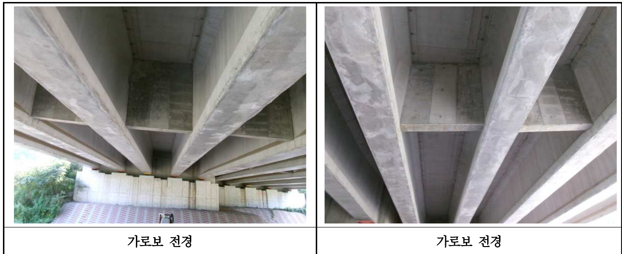
【사진 17.3.31】 가로보 전경
