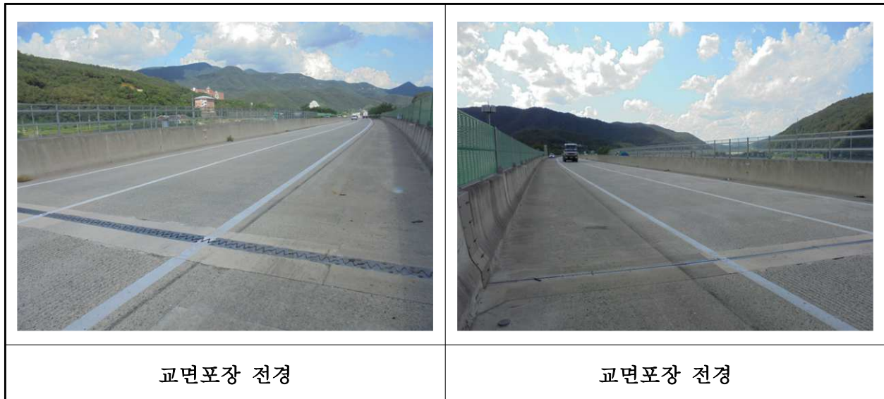
【사진 17.3.44】 교면포장 전경
