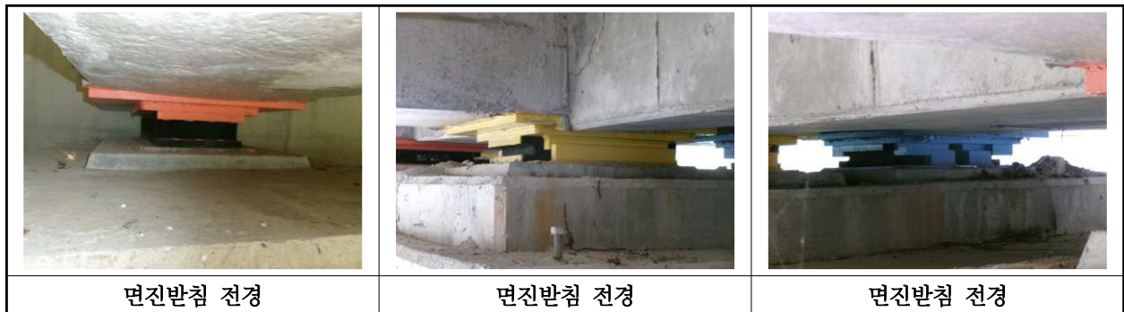
【사진 17.3.37】 교량받침 전경
