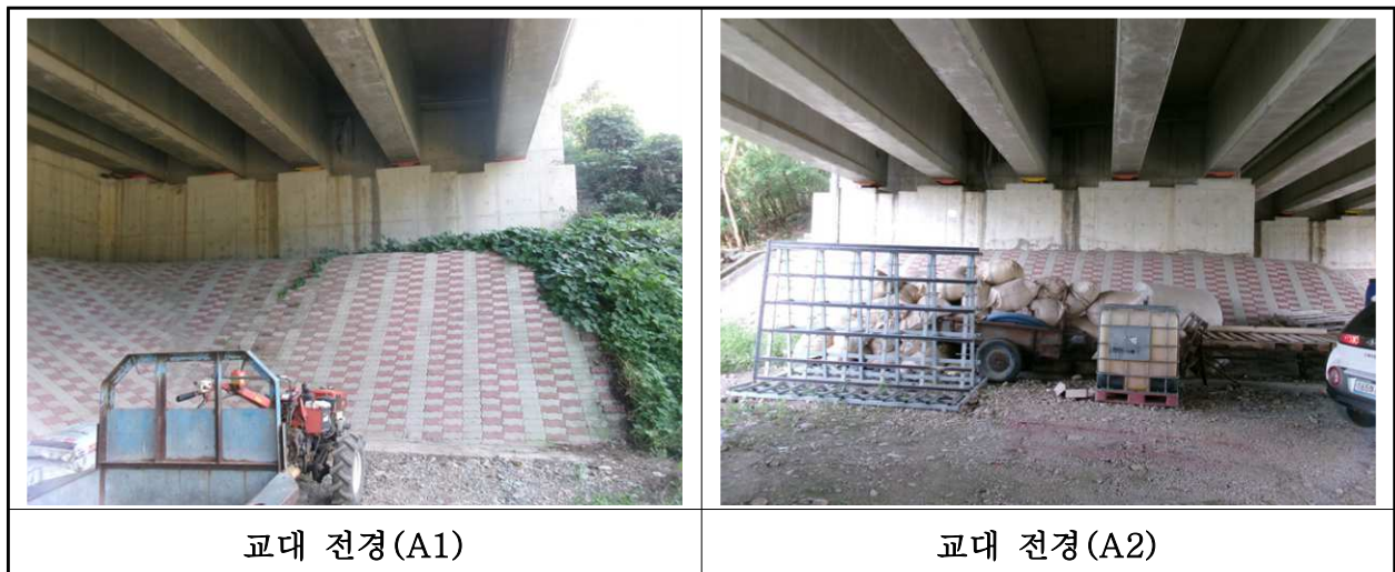
【사진 17.3.8】 교대 전경
