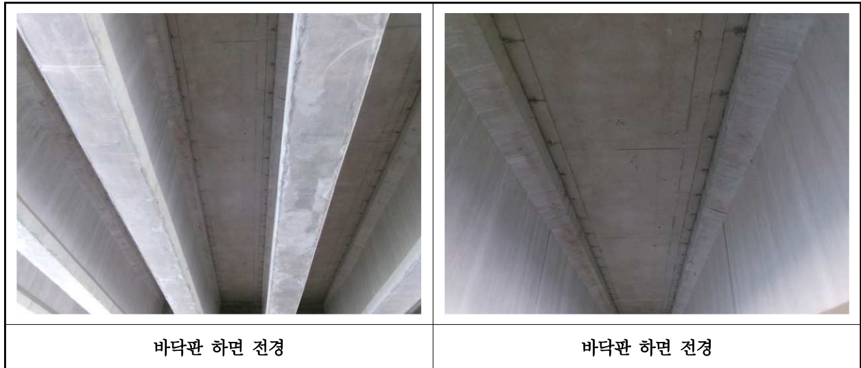
【사진 17.3.2】 바닥판하면 전경
