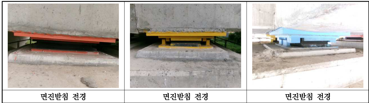
【사진 17.3.12】 교량받침 전경
