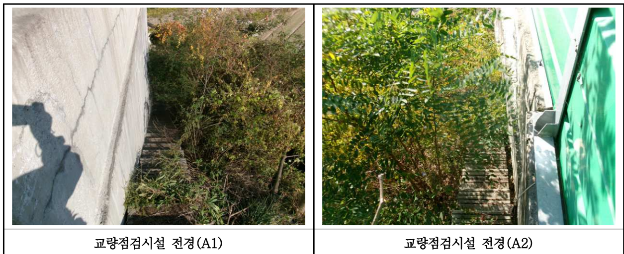
【사진 17.3.50】 교량 점검시설 전경
