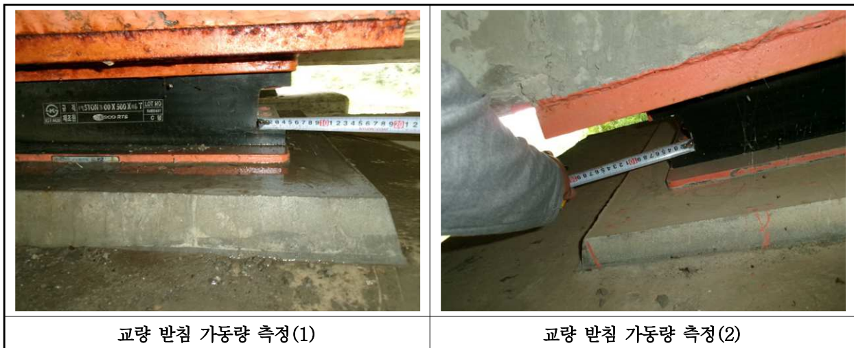
【사진 17.3.15】교량받침 이동량 측정
