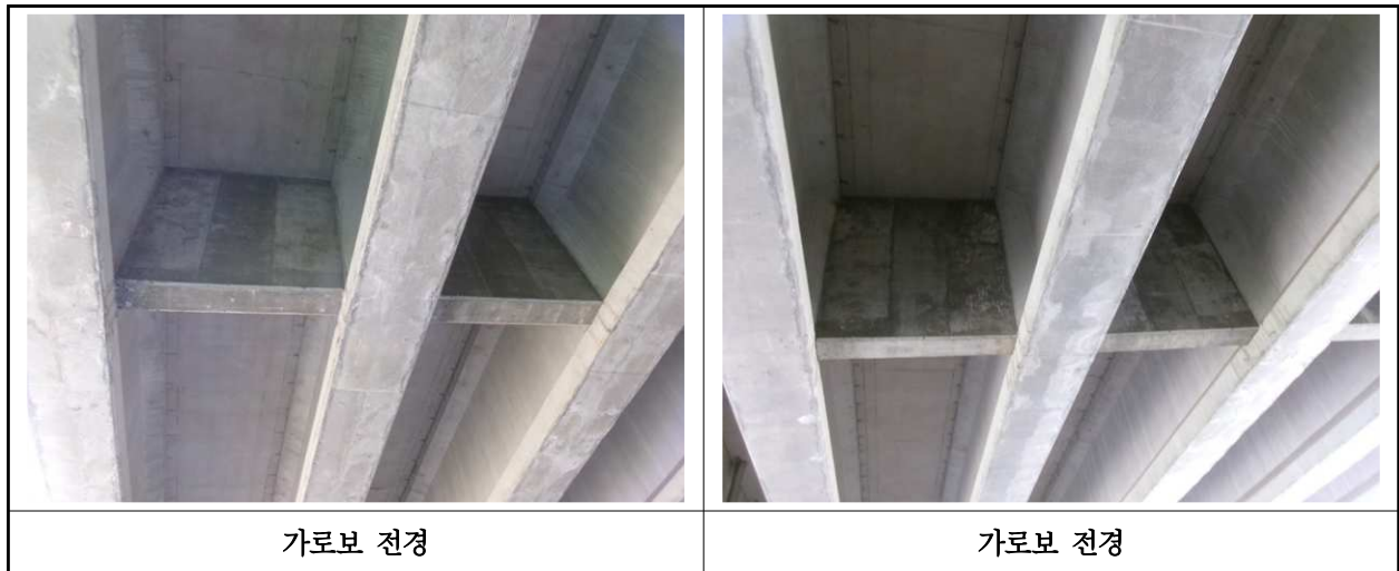
【사진 17.3.6】 가로보 전경
