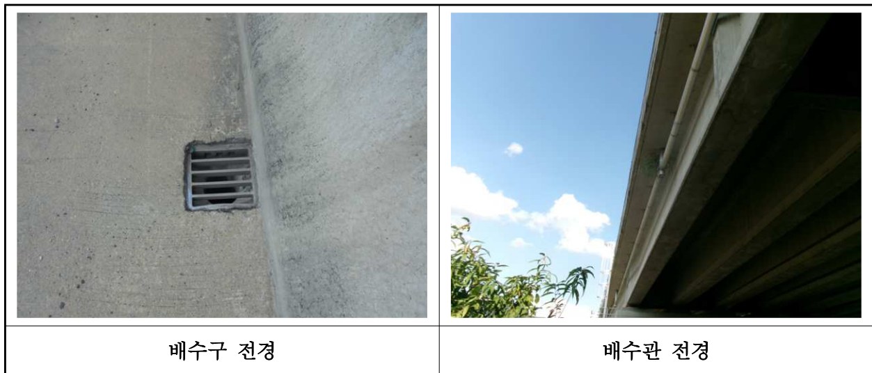
【사진 17.3.21】 배수시설 전경
