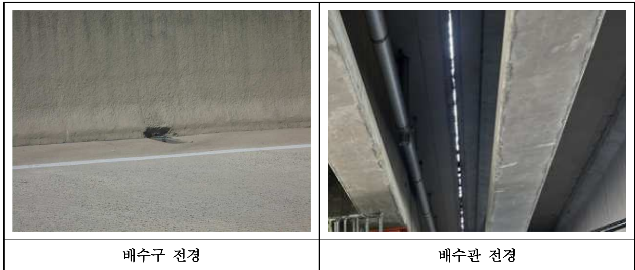
【사진 17.3.46】 배수시설 전경
